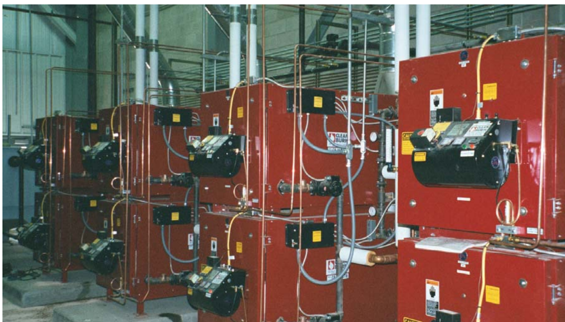
Рис.6 Каскадная установка водогрейных котлов
